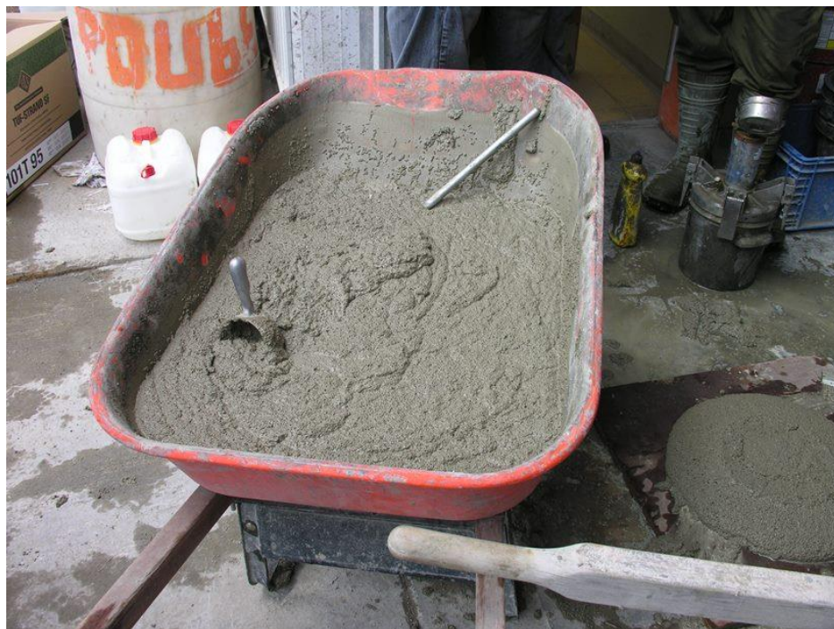
Figure 2 – Béton isolant à l'état plastique
